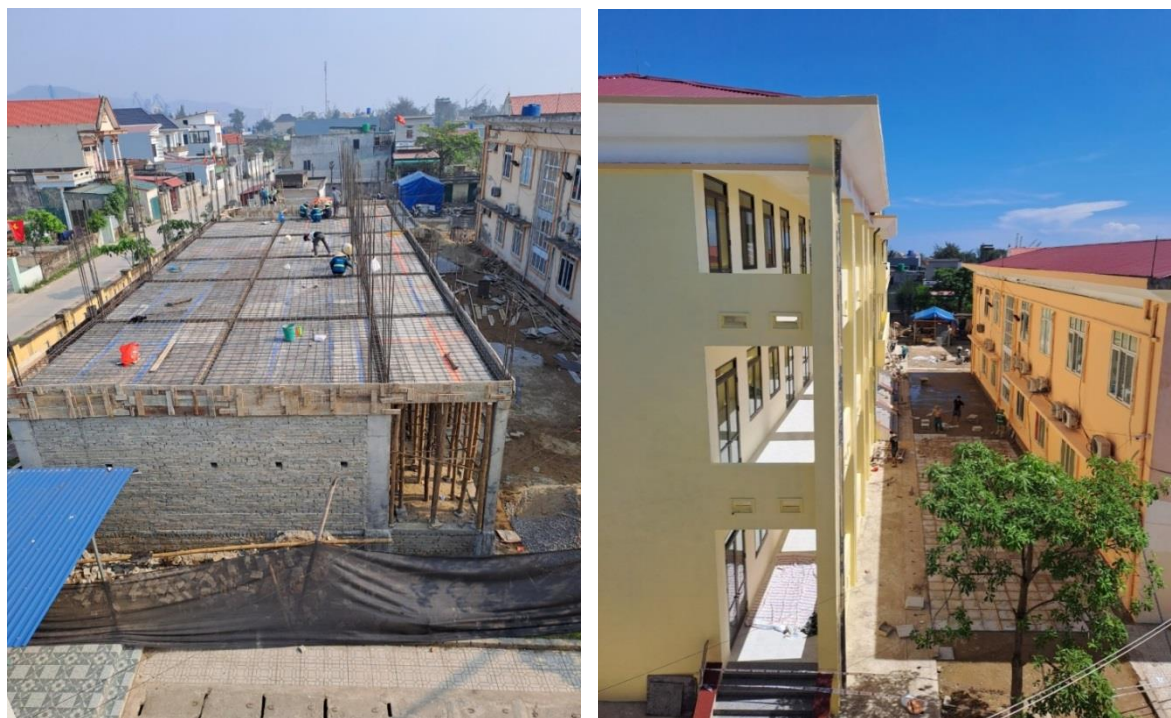
Xây dựng dãy nhà E, 2023
